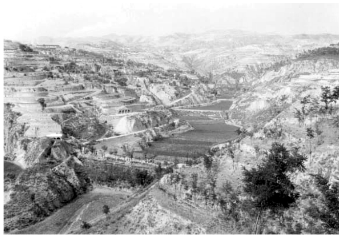
Projekt obnovy povodí „Loess II“: sedimentační hráze, terasy a zalesňování.
