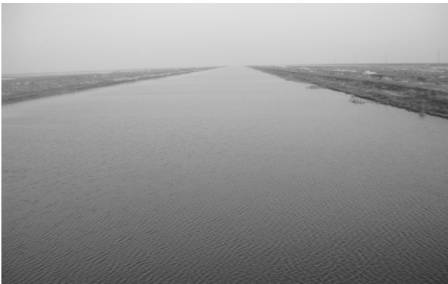
Obr. 2. Odvodňovací kanál Major Outfall Drain (Saddam River): průtok 120–200 m 3 /s, šířka 600 m.
